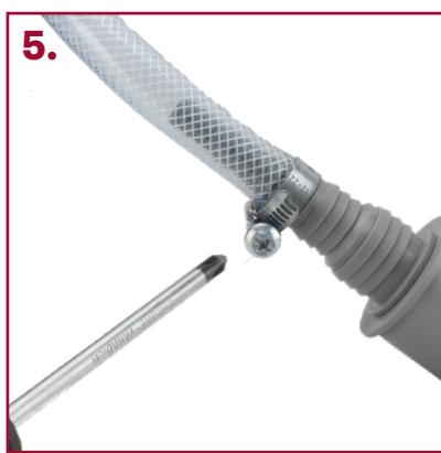
Hadice se dále napojí do odpadního potrubí a zajistí se druhou hadicovou sponou. Doporučujeme připojit hadici do odpadního potrubí pomocí redukčního nástavce (není součástí balení).
